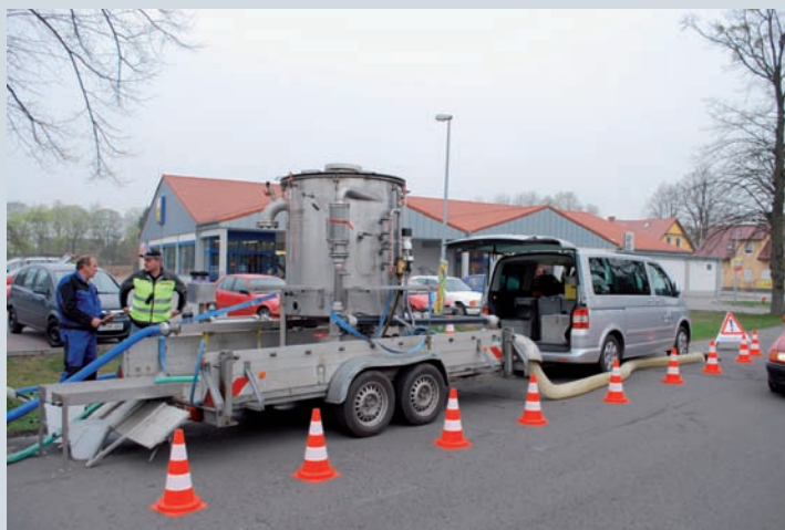
BILD 8: CO 2 -Reaktor für die Herstellung des Spülwassers (oben), Niederdruck-Hochsatz Filter am Auslass-Hydrant zum Nachweis von Wasserasseln (unten)
